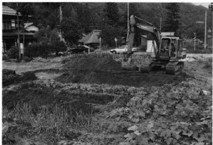
◀ 重機による表土はぎ
