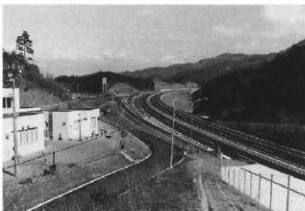
十二遺跡現況（下り線坂北パーキングエリア）
