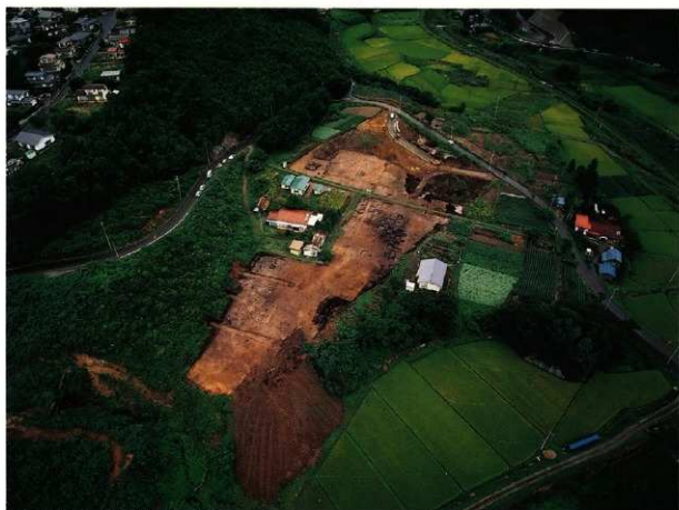
向六工遺跡 全景（南上空より）
