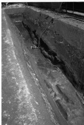
NR01掘削状況(拡張後・南から)
