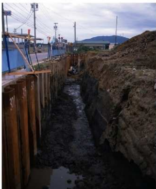
③調査区東側作業風景
