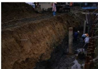
②C遺構群付近作業風景
