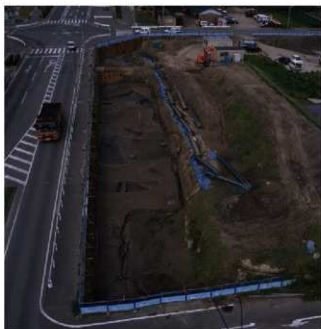
⑤調査区全景(南西より)
