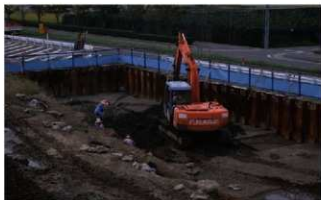
⑥湧水層確認掘削
