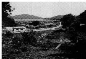
粗掘り終了時 (北から)
