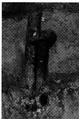
煙道部完備（東から）
