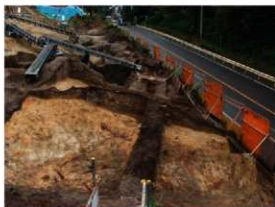
写真 15 遺物包含層 D-D'セクション(西より)
