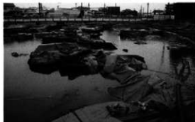
写真1 95調査区湧水状況
