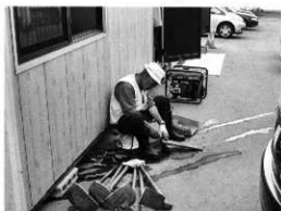
整備作業風景 (南東→)
