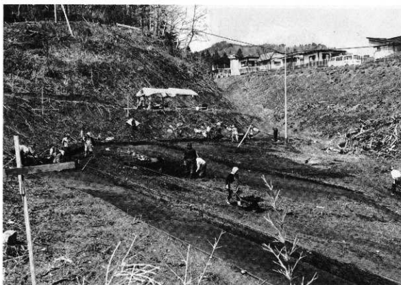
作業風景 (右上は国道45号線)
