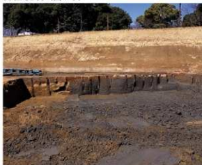
96区 SA03 (南東から)
