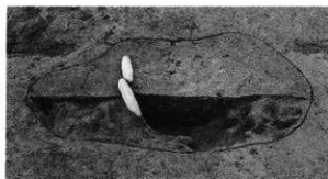
(4) SB 451 A 炉断面
