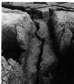
(6) 4区 SD 401の底部に認められる 地震によると思われる亀裂
