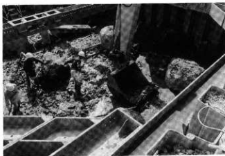
重機によるヘド口除去状況
