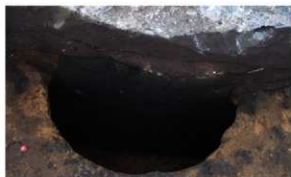
写真2-188 SK-102セクション(S→)
