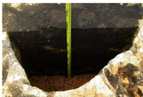
写真2-154 SK-004セクション(NE→)
