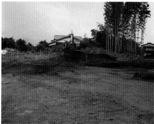
Pla.5 調査区表土剥ぎ (南東から)
