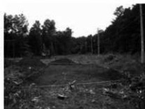
写真4 1T 掘削状況
