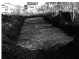
写真8 3T 完掘状況
