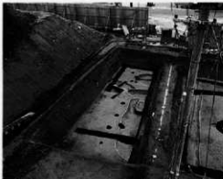
SA6005 (89E区) 西から
