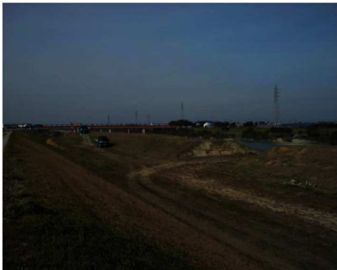
調査前風景（南東から）
