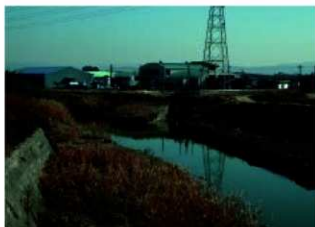
図25 木戸樋門(西から)
