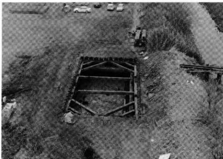
23, 橋脚部分KP1全景 (南から)
