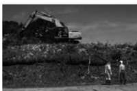
柴山(1)遺跡②:調査状況
