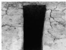
第37号陥し穴 埋土
