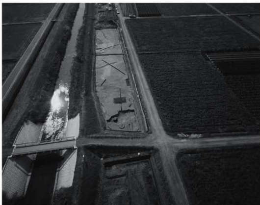
(1) A区第1面全景（北東から）
