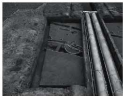
(1) 北側全景 (北西から)
