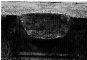
6 SE15 断ち割り状況 (北から)
