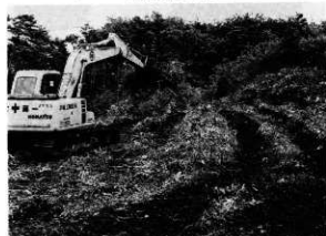
B区雑物撤去状況
