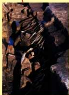
土砂が崩れない ための杭列
