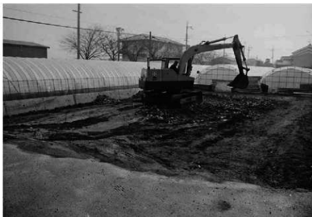
1. 調査前の状況
