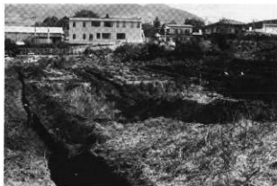
ト レ ン チ (西から)
