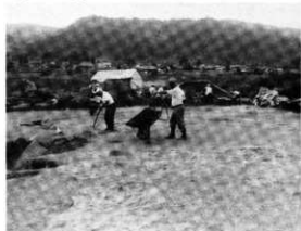
土盛保存が決まり、各遺構に砂を入れた。
