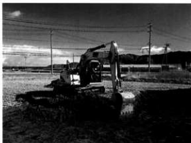
バックホーによる表土掘削 (11月21日)
