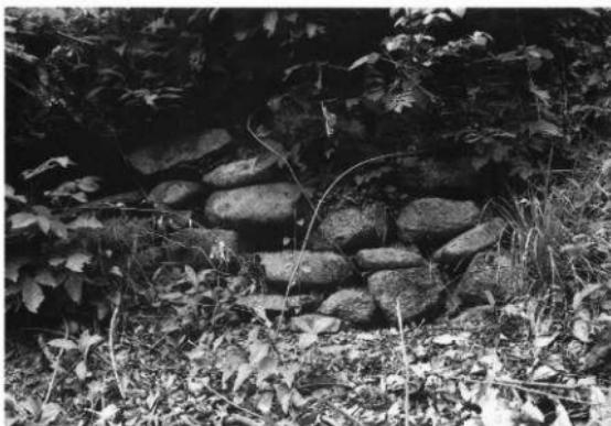
図版 6 復旧作業で参考にした本郭東側斜面に残る石積
