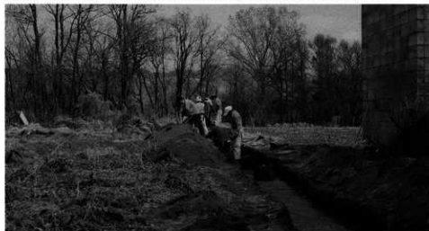
B地区作業風景
