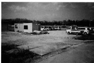
井戸尻遺跡駐車場造成・ハウス設置状況
