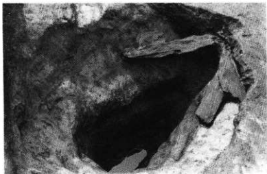
写真5 SK-101 板材組み方状況
