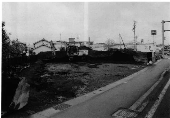
西八日町遺跡VI表土除去作業（西から）
