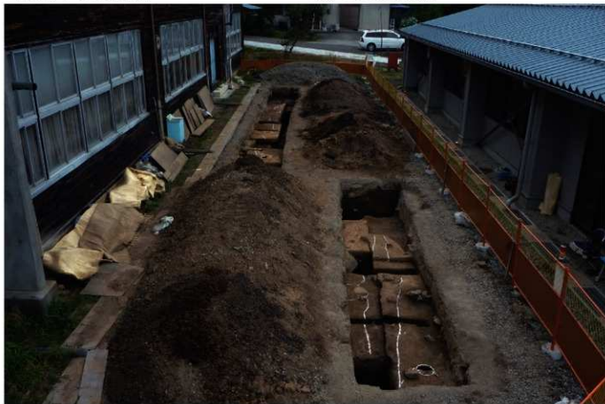
2C1 トレンチ全景（手前：2C1b トレンチ、奥：2C1a トレンチ、西から） 画面奥の道路は長安寺参道
