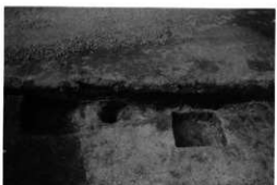
H3号住居址堀方 (南から)
