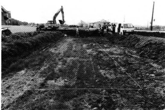
調査前全景(北から)
