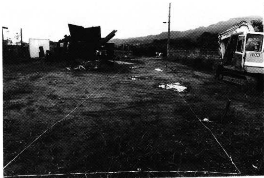
調査前全景(南から)
