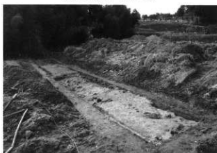
第21発掘区 (北東から)
