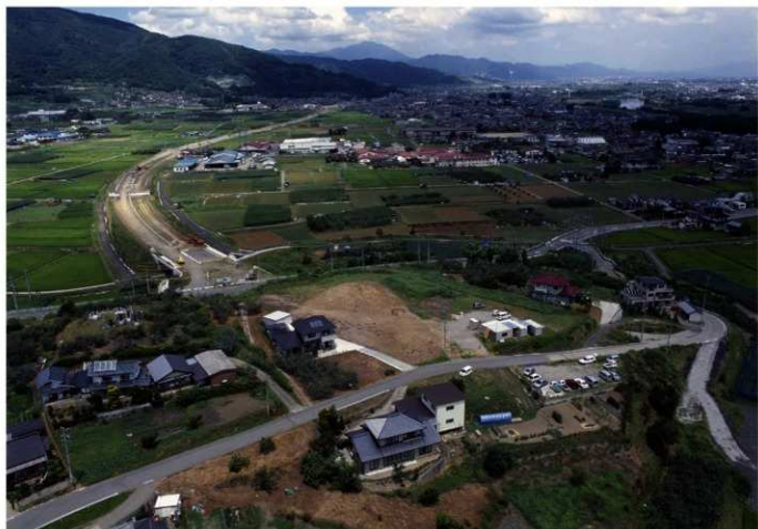
八幡道跡群遠景（道路建設状況、奥は稲荷山～篠ノ井方面）
