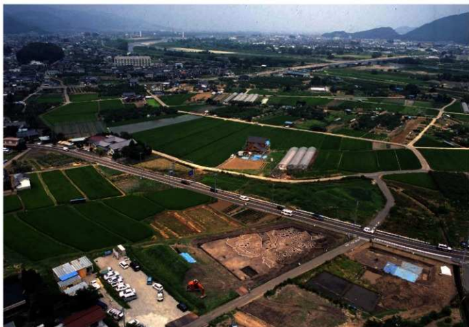
調査区全景 平成14年度 南西より
