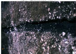
SD32 完掘 北より
