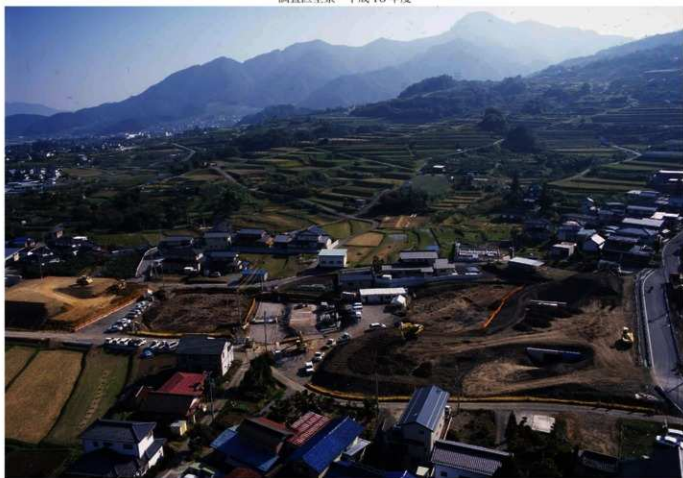
調査区全景 平成19年度 北より
