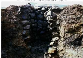
井戸 SK2315 石組み断面 北より
