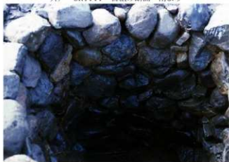
井戸 SK1123 石組み 東より
