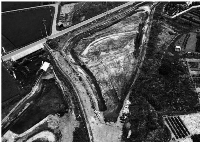
2. ⑤区 水田C 全景南上空均
