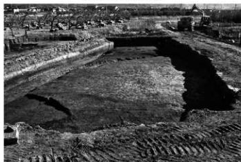
3. ①-2区 全景 (西より)
