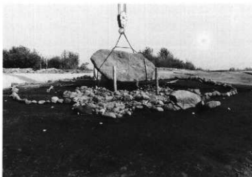
① 3号墳奥壁除去 作業風景（南より）
