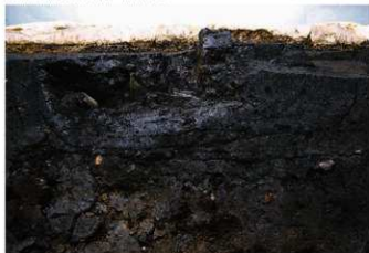
青銅器埋納坑 下部に発生した亀裂（現場より切り離し移動後）
