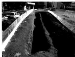
グラウンド地点 トレンチ完掘状況
