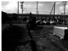
グラウンド地点 トレンチ掘削状況
