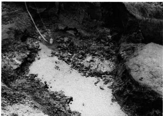
b. SD-103 完掘状況 (北から)
