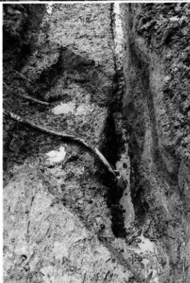
b. SD-101 掘り下げ状況
