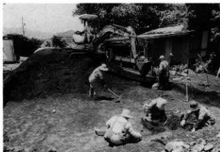
24 作業風景 (南東から)
