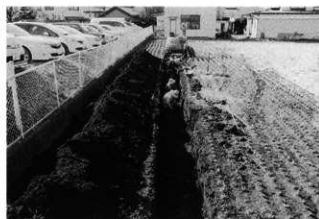
(4) 作業風景 (北東から)
