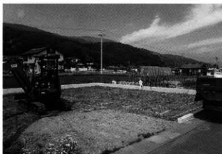
22-12 中村遺跡 (1) 調査区現況 (東から)
