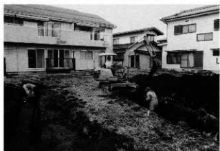
(2) 作業風景 (西から)
