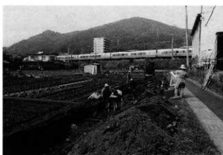
(12) 作業風景 (南から)
