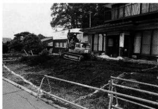
22-6 中御前遺跡 (1) 調査区現況 (南東から)
