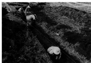
(5) 作業風景 (東から)
