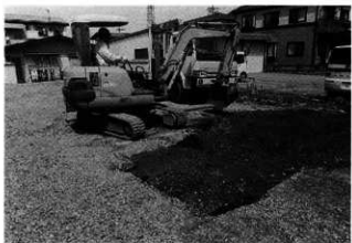
22試-5 構井・阿弥陀堂遺跡 (1) 調査区現況 (南から)
