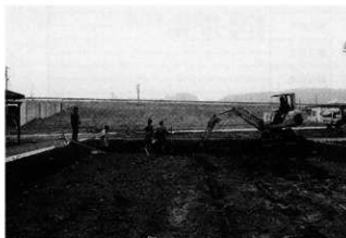
(5) 作業風景 (南西から)
