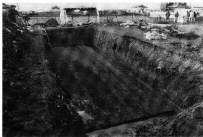
第IV層上面遺構検出状況 (東南から)
